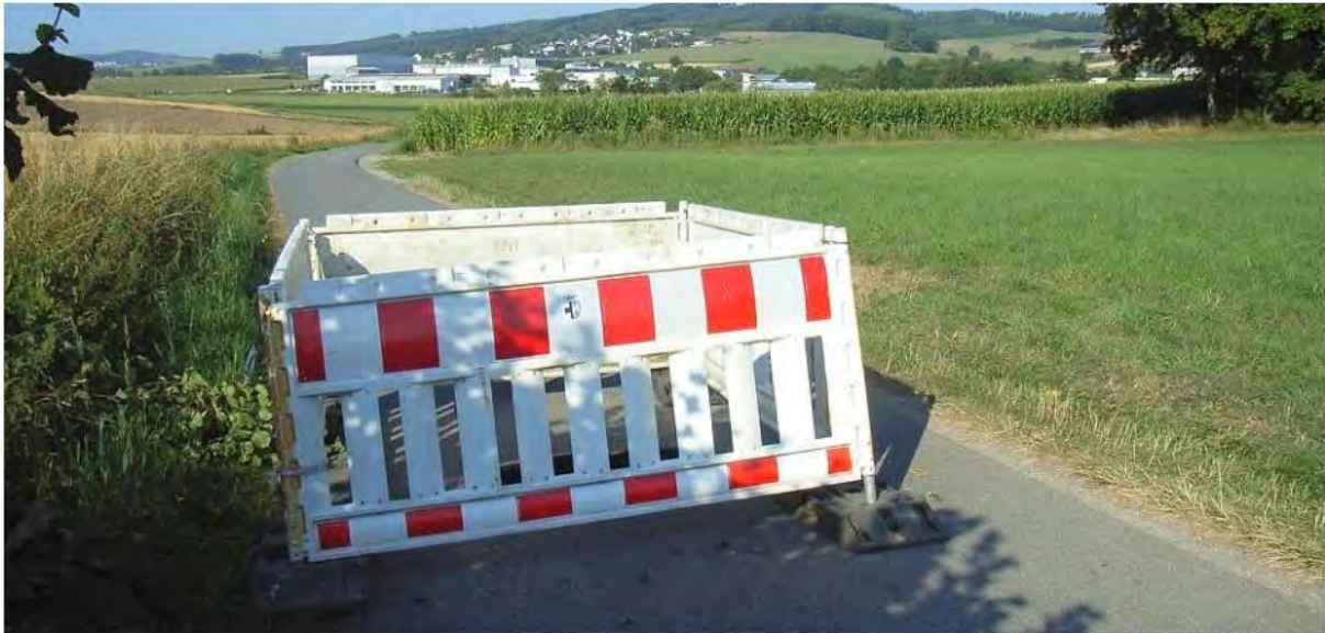
Wirtschaftsweg am Braukessiepen: Auch Pisten jenseits der großen Straßen müssen erneuert werden.
